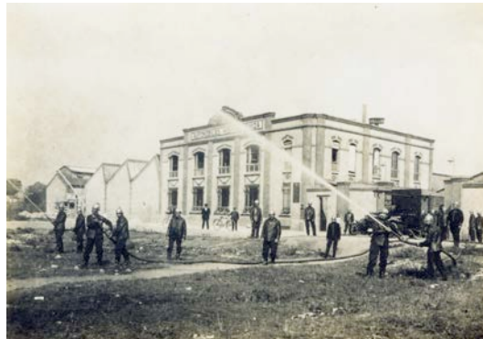
Essai de lances d’incendie devant le bâtiment administratif de l’usine Hispano-Suiza à Bois-Colombes, années 1910 (AMBC, 44 NUM 43 – don de René Moreau).
