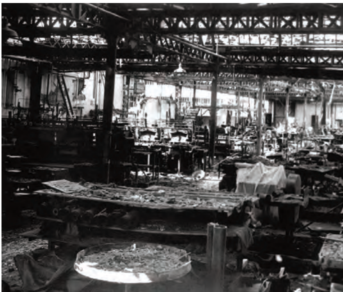
Doc n° 35 : L'usine Goodrich à Colombes après le bombardement du 30/05/1942 (AMBC, don de M. Deville)
