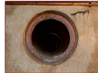
Une des bouches d'aération.
