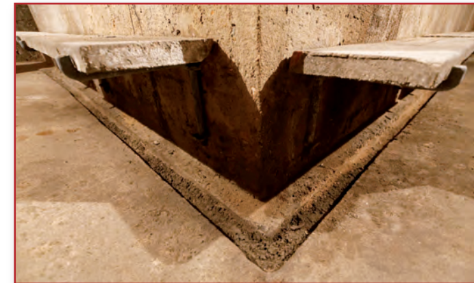
Une rigole court sous les bancs tout le long de l'abri.
