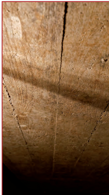
Traces du coffrage en bois au plafond de l'abri.
